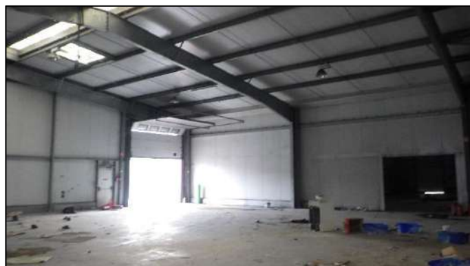
Structure des bâtiments
